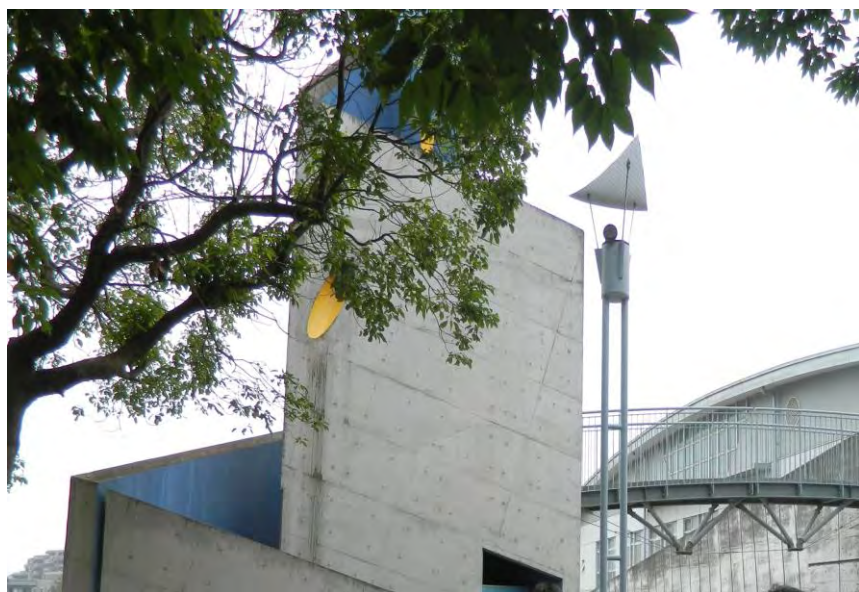
シンボルタワー
